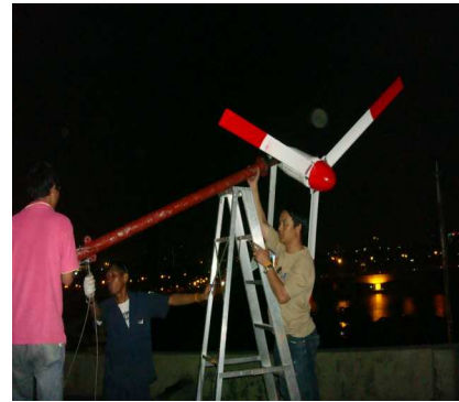
รูปที่ 23 แสดงการติดตั้งชุดตัวอย่างกังหันลมผลิตกระแสไฟฟ้า
