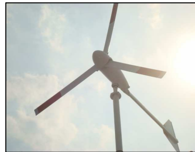
รูปที่ 28 กังหันลมผลิตกระแสไฟฟ้า 200 วัตต์ที่ประกอบโครงสร้างเสร็จสมบูรณ์แล้ว
