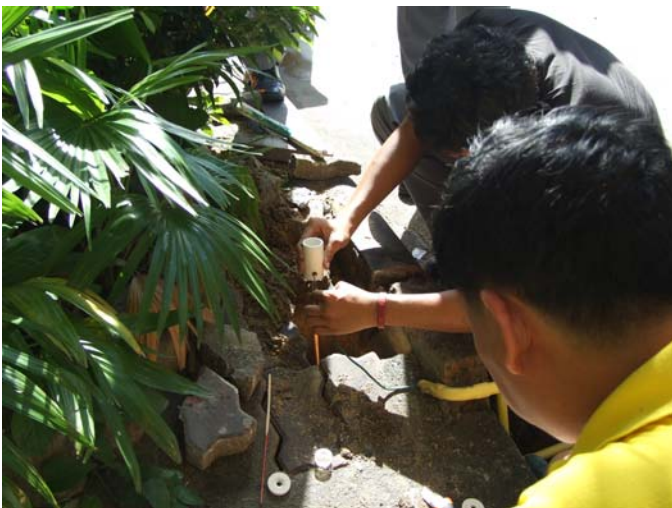
ทำการเดินท่อสายกราวด์ ติดตั้งแท่งกราวด์ตามจุดที่เหมาะสม และตรวจสอบการทำงานของเครื่องอีกครั้ง
